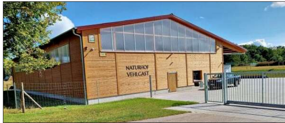
Eine moderne Halle für den Naturhof Vehlgest ist in Damerow entstanden. In dieser befindet sich auch das Büro des Betriebes.
